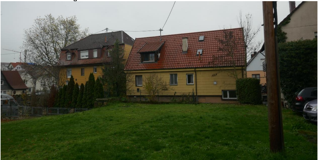
Blick über den Hof zur Rückseite der Gebäude an der Lauffener Straße
